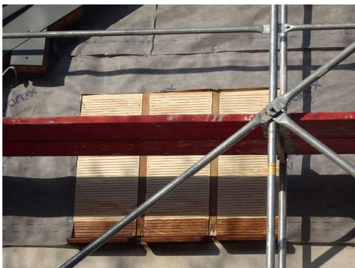
Hotel w Rudzie Sułowskiej w trakcie remontu
