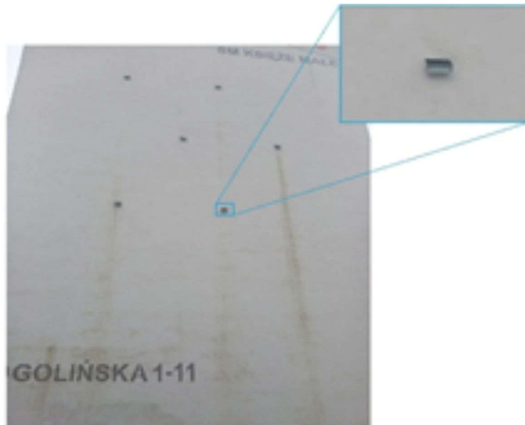
Fot. 41. Montaż dodatkowych rynienek. Autor: Ewa Zuber
