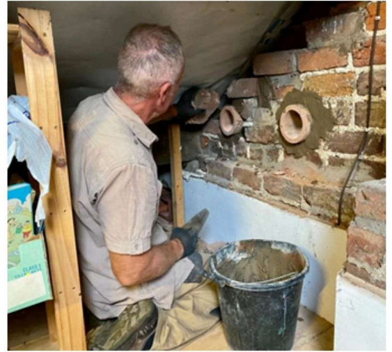
Montaż tuneli do przejścia przez ścianę
