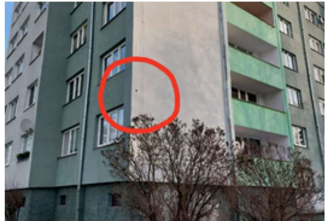
Wejście do kryjówki borowców znajdujące się w pobliżu okna
