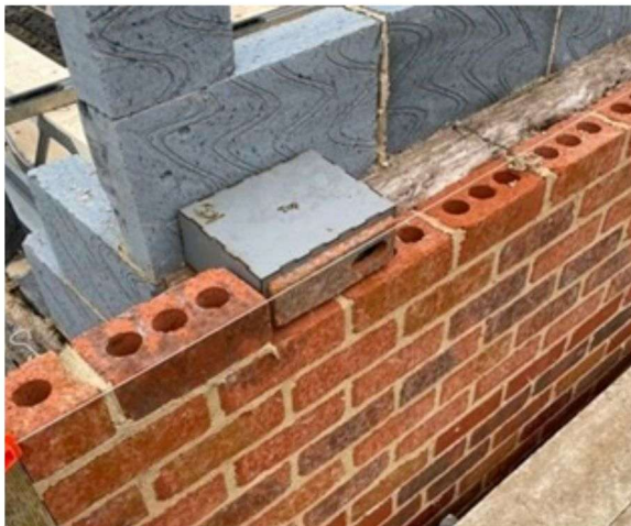
Budka dla jerzyków typu cegła pojedyncza. Od zewnątrz zlicowana ze ścianą, przechodząca przez warstwę cegieł na podwójną głębokość
