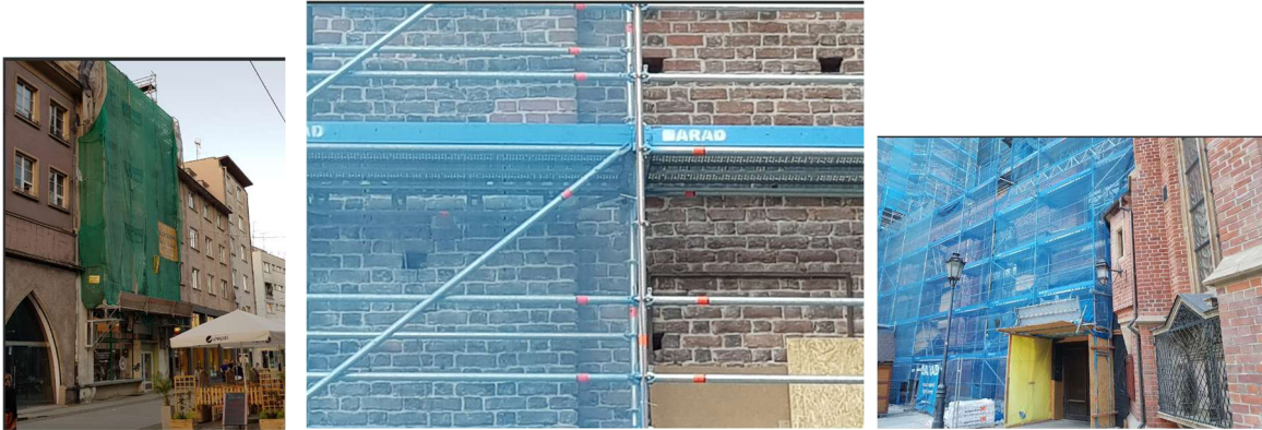
Fot. 24 Montaż siatek na rusztowaniach. Autor: Roman Guziak
