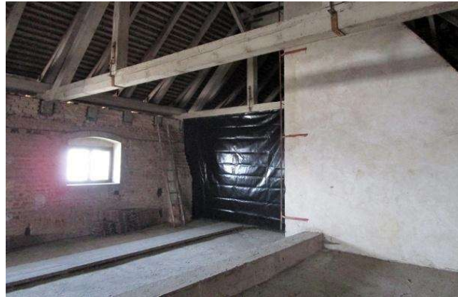
Fot. 25 Przegroda rozdzielająca dwie części strychu. Autor: PTPP „pro Natura”
